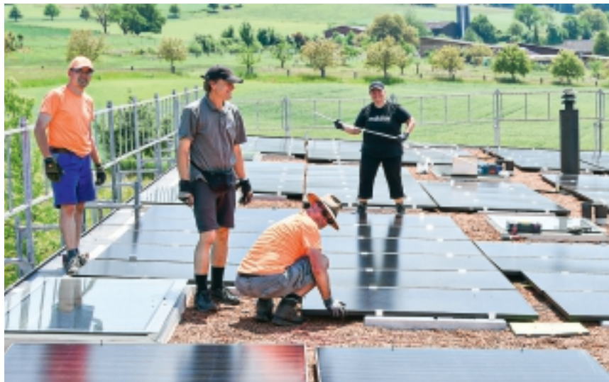
Marke Eigenbau: 258 Solarpanels wurden auf einer Fläche von 700 Quadratmetern verlegt
